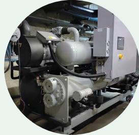
改善與汰換高能耗設備
