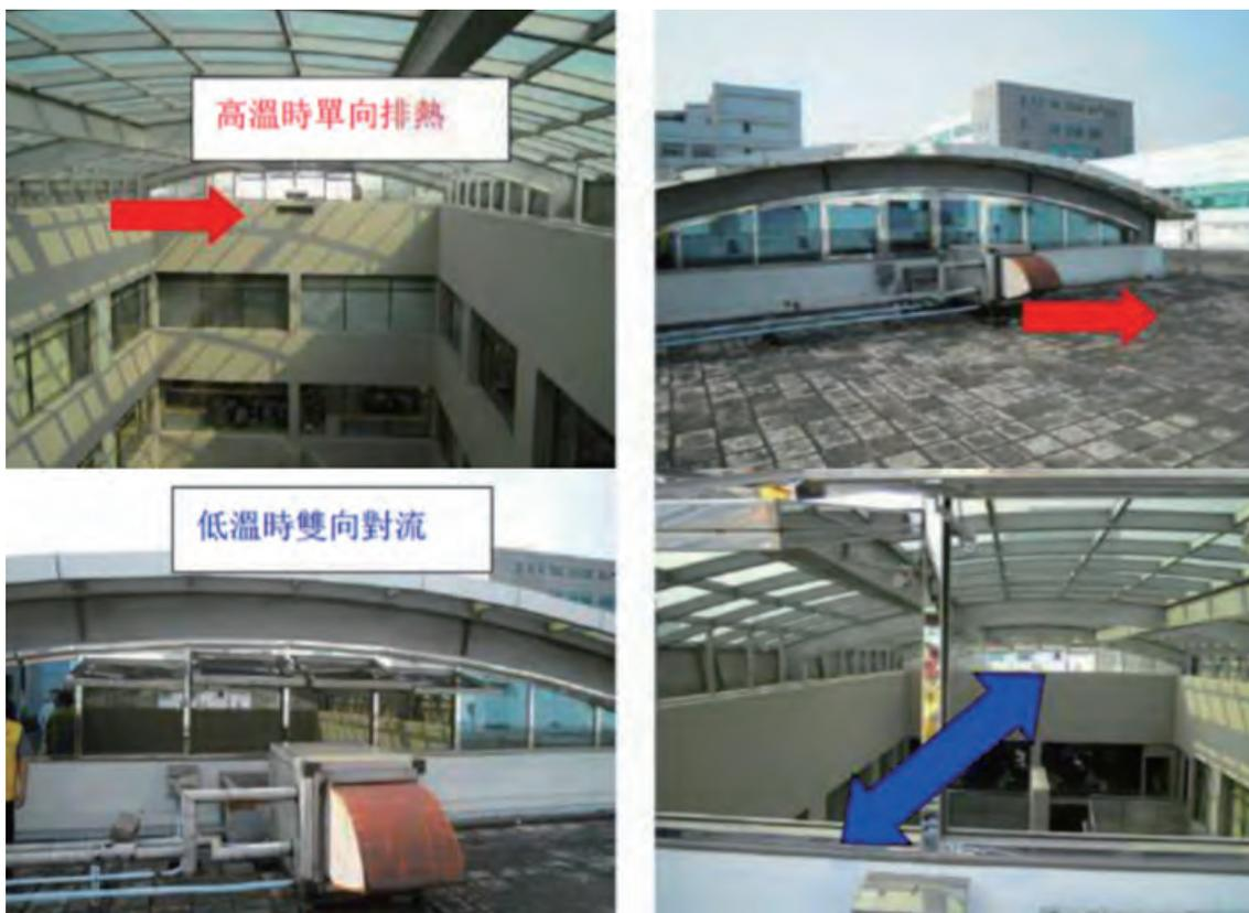
**措施二：**位於五樓開放式餐廳夏季熱源大，因無天花板分隔容易造成空調出口回風短循環，診斷團建議將出風口改為格柵下吹型式，以縮短空調開啟時之降溫時間，提高空調之效能以減低無效之耗能。
